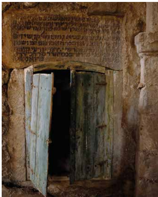
Alkosh: Eingang zum Grab des Nahum (vor den Renovierungsarbeiten 2019).
